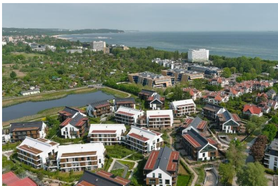
fot. widok z lotu ptaka
